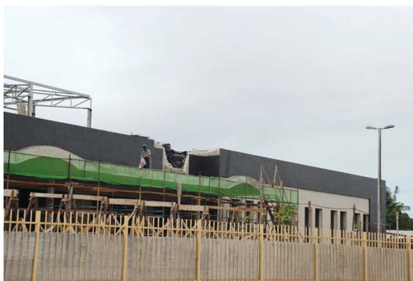
Construção da Upra está perto do fim
