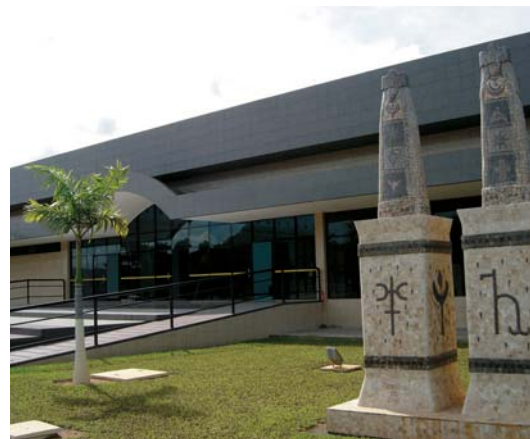
Fachada do prédio central no CRCN
